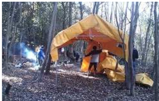
仮設のテント小屋を建てる
