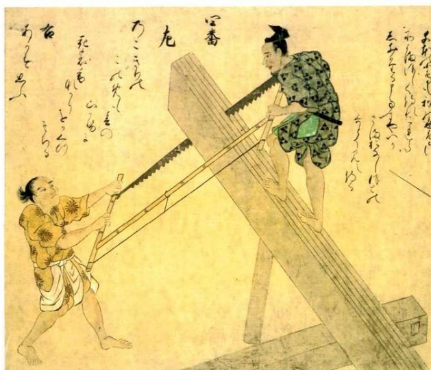
『三十二番職人歌合』より大鋸引 15世紀 サントリー美術館所蔵 斜めに立てかけた材の上と下にいる人が大鋸を交互に引いて、大きな材を一気に挽く
